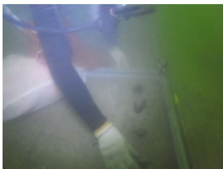
移植作業の様子
