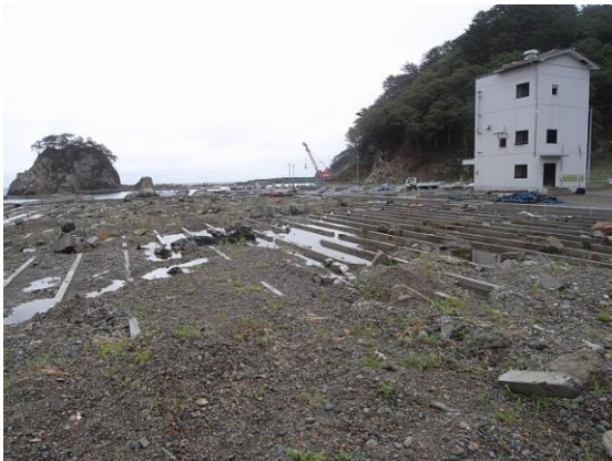
写真3 被災した重茂漁協アワビ種苗 生産施設 (2011年8月19日)
